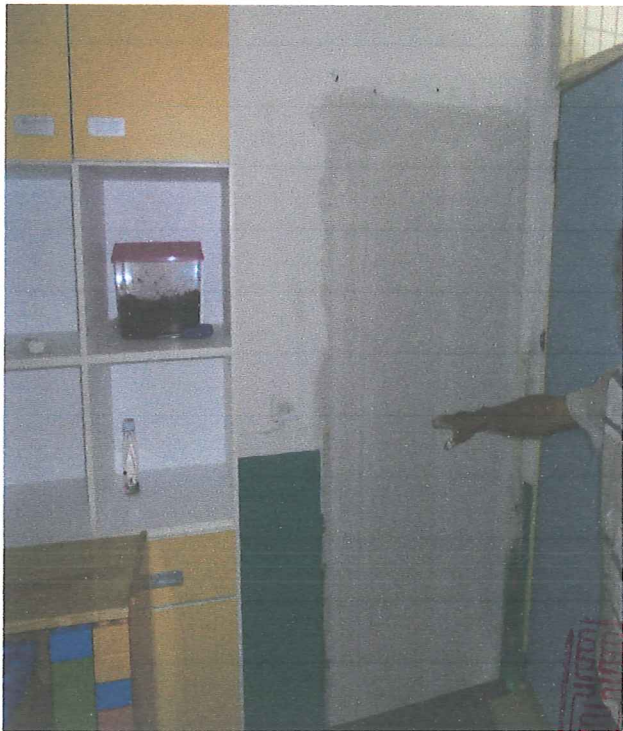
牆面封閉油漆批土後
