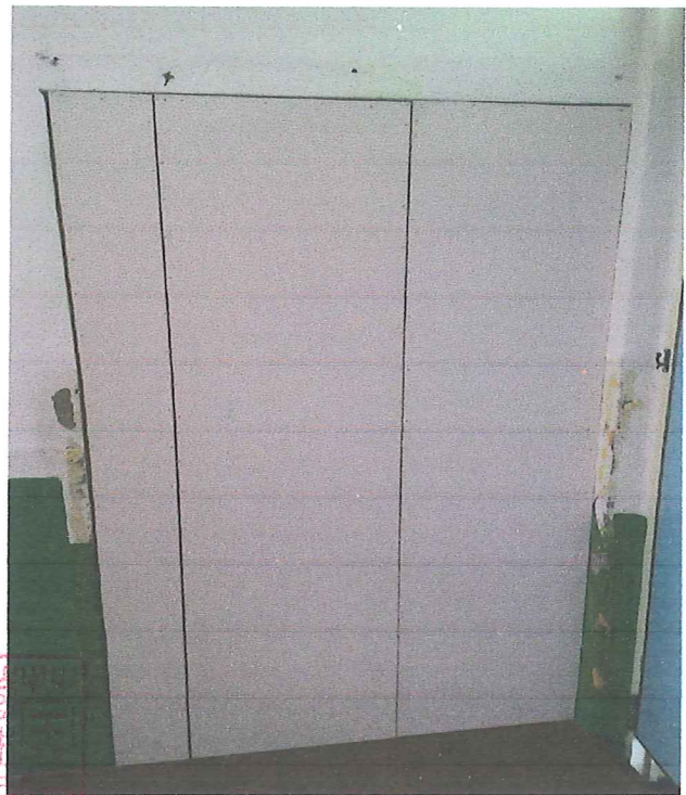
牆面封閉矽酸鈣施工中
