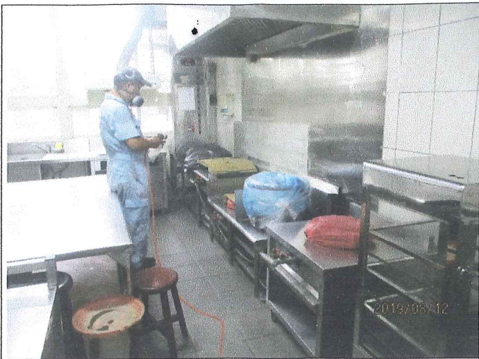
廚房冷霧式空間噴灑作業情形
